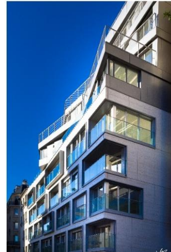
Architectes : Thierry Bresdin et Pacôme Bommier / © Vincent Mazet
