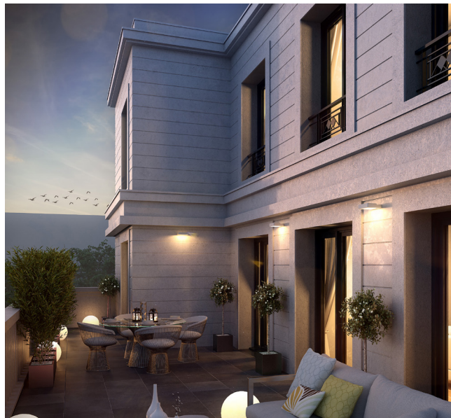
Architecte : DGM & Associés
