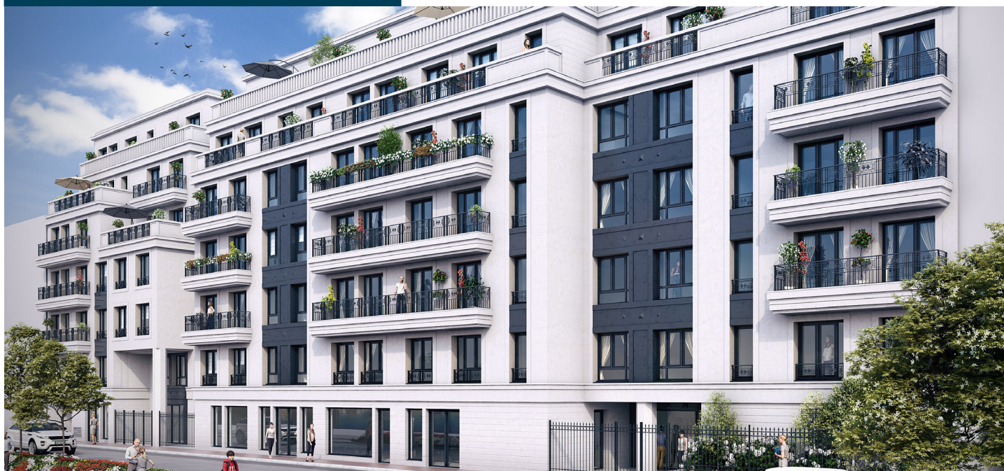
Architecte : DGM & Associés
